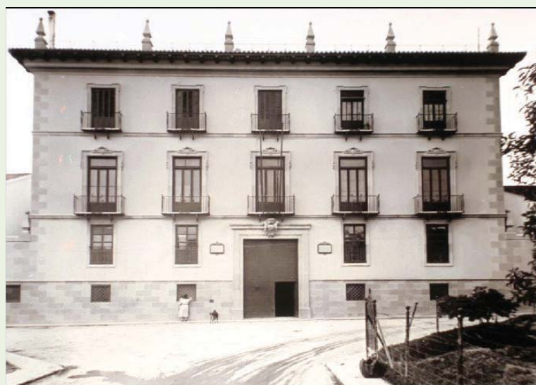
Fachada principal del edificio de la Estación de Fitopatología (placa derecha ) y la Estación Naranjera (placa izquierda ) en Burjassot, Valencia, hacia 1934 (Archivo IVIA).
